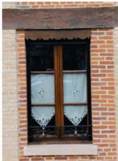
**Linteau** : Traverse au-dessus d'une baie recevant la charge de la partie supérieure et la transmettant aux points d'appui.
