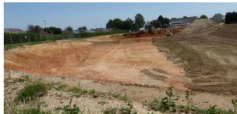
Figure 8 : Ouvrage hydraulique en cours de réalisation
