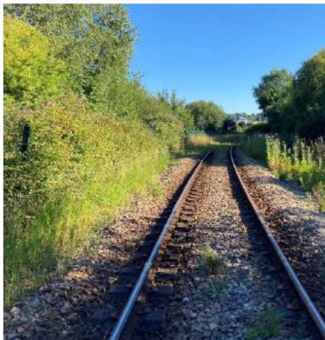
La voie est clôturée côté impasse de la rive
